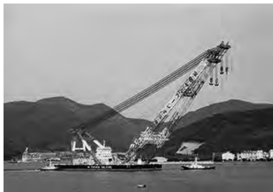
図 23 浮きクレーン
