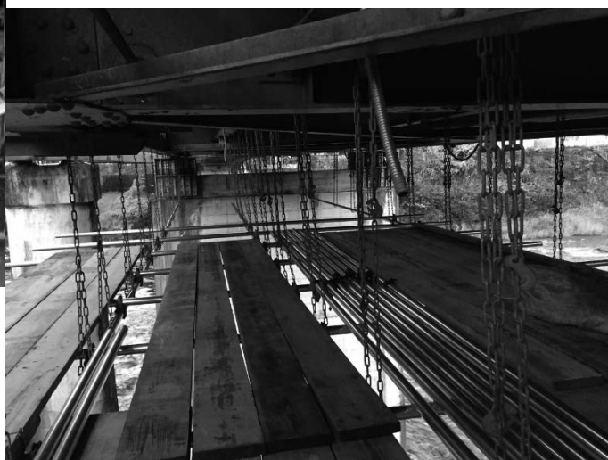
(つり足場の写真) 18
