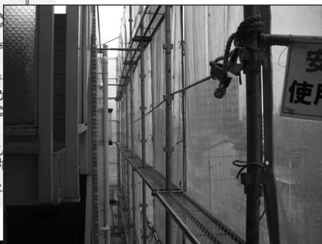
(一側足場の写真) 17
