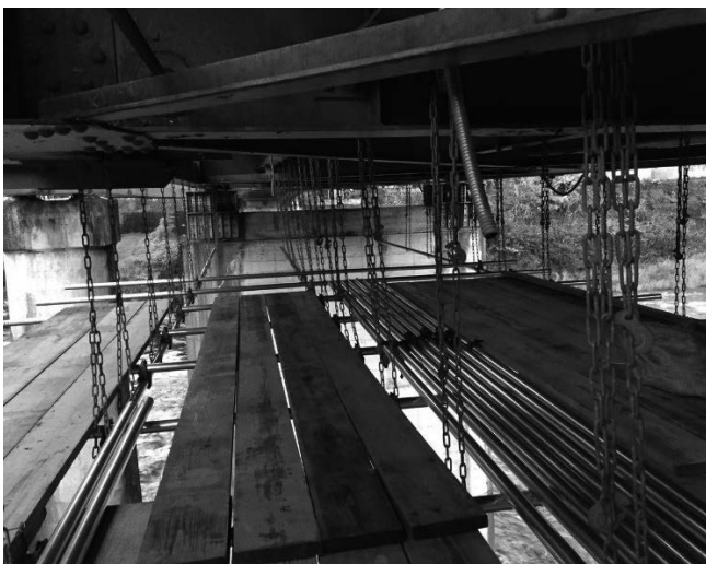
（つり足場の写真） 19
