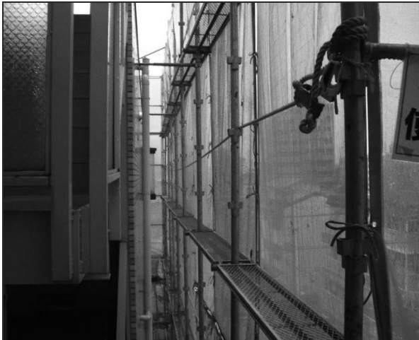
（一側足場の写真） 18
