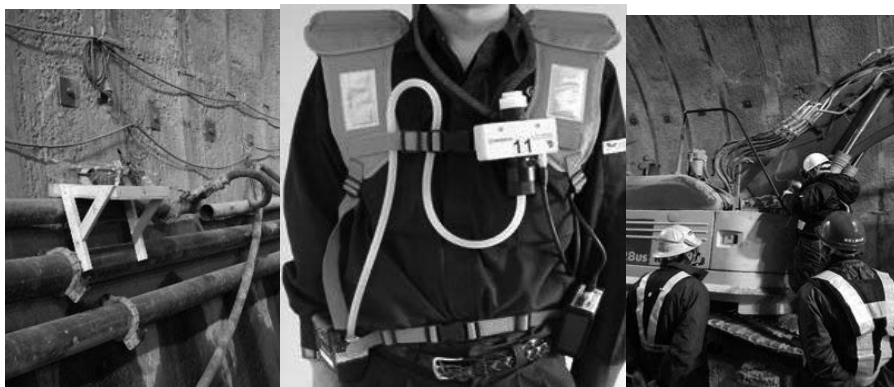
【図表 1-18：定点測定・個人サンプリング・車両系機械を用いた測定（左から）】
