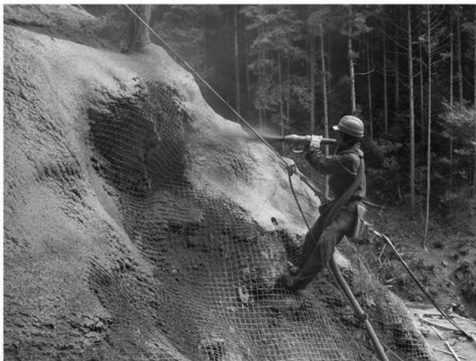
写真-3 吹付工施工状況
